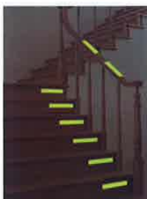
蓄光プレート
